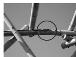
写真 1 7 d 上弦材破断
