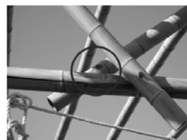
写真 1 7 a 込栓破断
