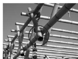
写真 1 7 c 込栓破断
