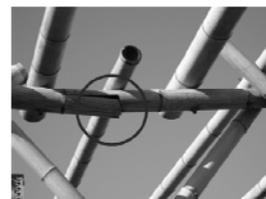
写真 1 7 b 上弦材破断
