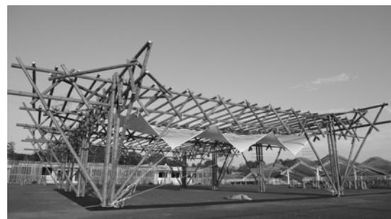
写真13 竹材継ぎ手2によるトラス建物
