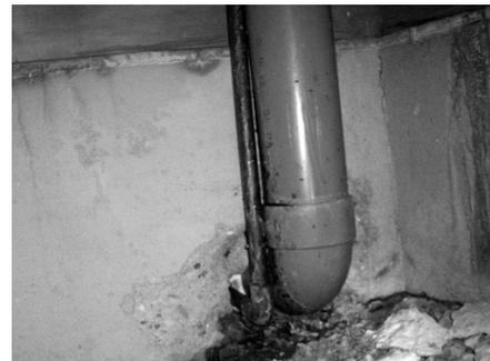
写真-2 貫通孔回りの杜撰な施工例
