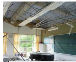
音楽室の天井材の脱落
