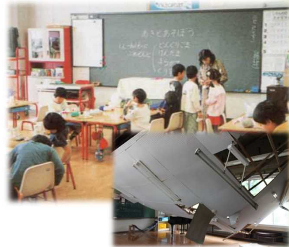
雨漏りによって天井吊り部材が腐食して突然落下
