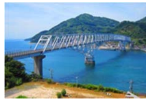
図2 豊浜大橋の現況
