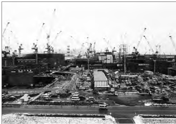
建設中の再処理工場（2000年）
