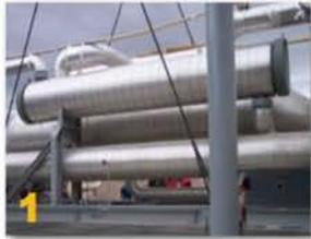
Beowawe発電所は、設備内に従来からある地熱発電プラントからの排熱を使用した低温バイナリーサイクル発電所で、約17.7MWの従来の地熱発電プラント容量に1.8MWの発電プラント容量を追加している。当該プロジェクトは米国再生・再投資法の下でGeothermal Technologies Officeから一部資金提供を受けている。写真提供Terra-Gen社
