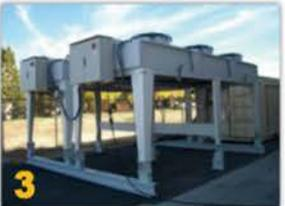
実証を行っており、プラント入口温度が300° Fに満たない地熱発電プラントでは初となる超臨界サイクルを商業利用している。同発電所は2012年9月から稼働しており、6MWの出力で発電している。
