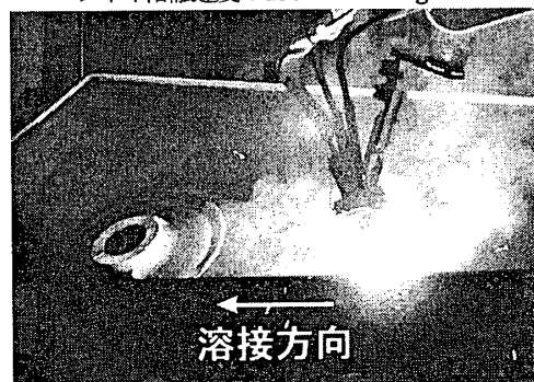
図10 実ワーク施工の様子
