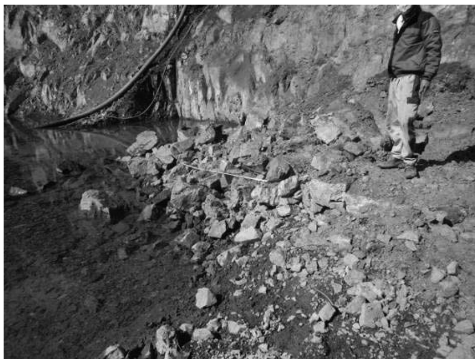
写真2 #1の発破後の状況
