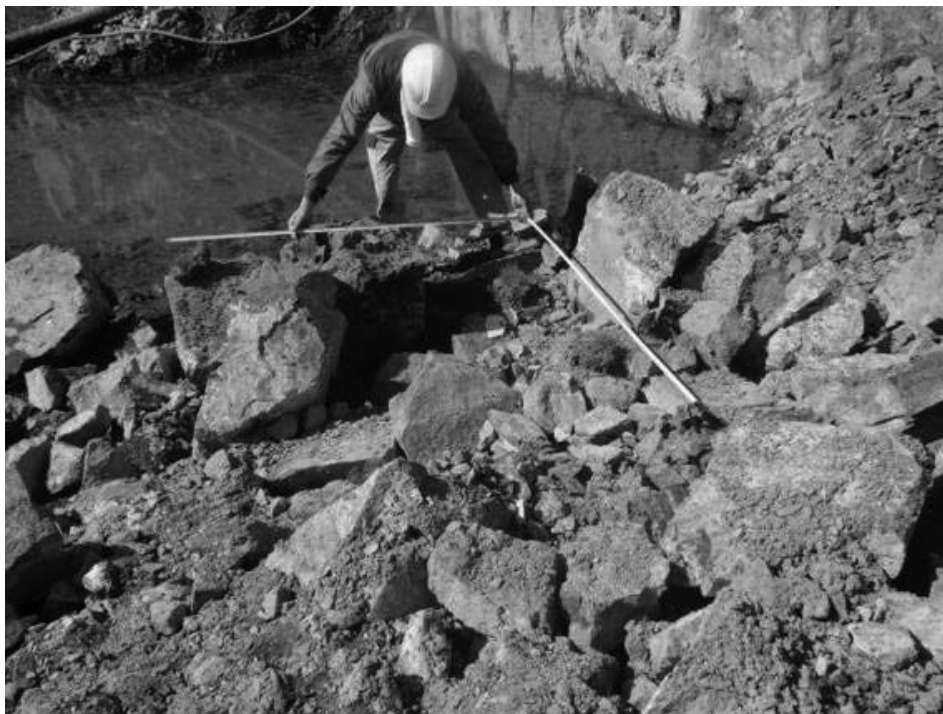
写真3 #2の発破後の状況
