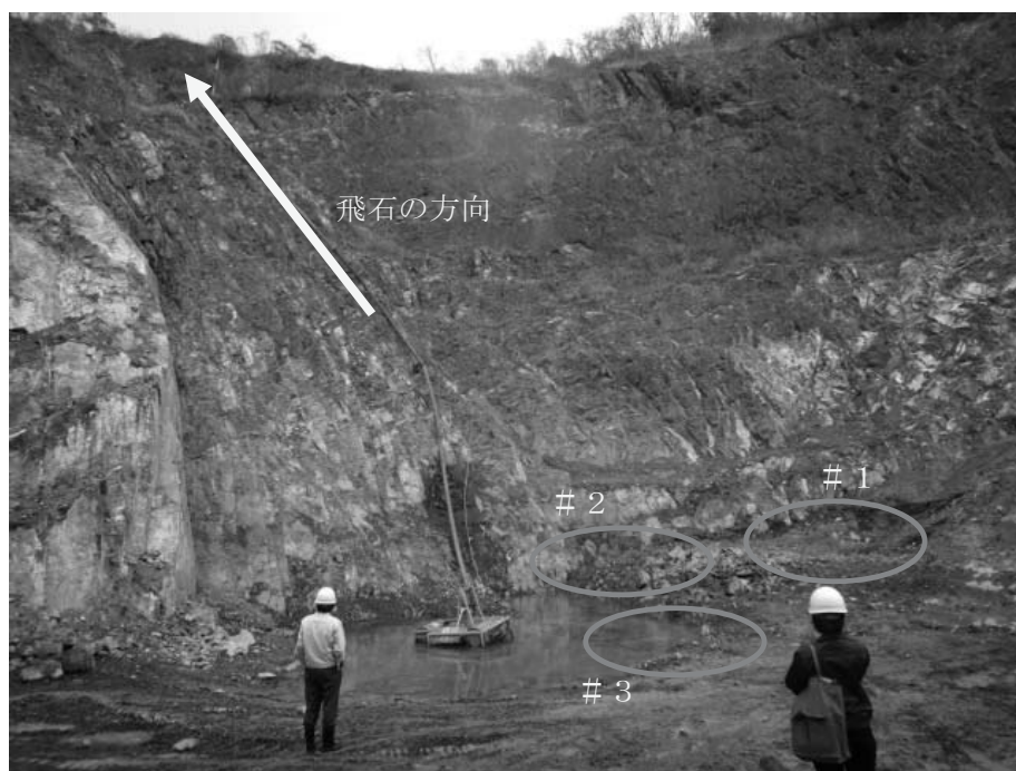
写真1 飛石発生現場
