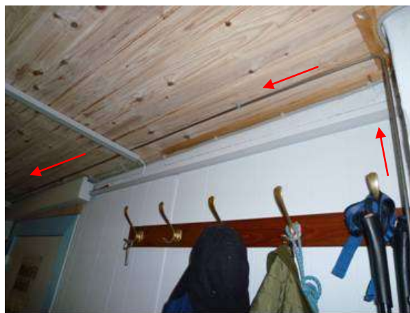
図 3. 3. 3. 8 屋内配管敷設状況
