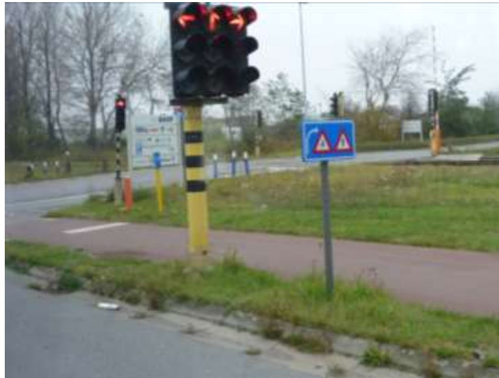
図3. 3. 2. 3 地上ポール設置状況
