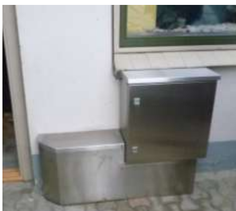
図 3. 3. 3. 7 減圧器外観（Honeywell 社製）
