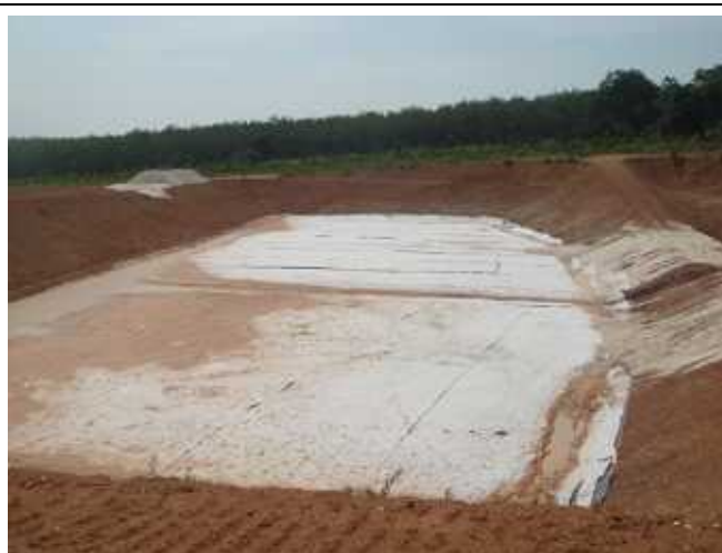
建設中の廃棄物最終処分場 全部で4か所の廃棄物最終処分場が建設予定されており、一つ目が建設中である。
