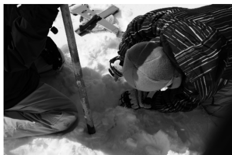
写真2 円の中心を決めて杭を立てる
