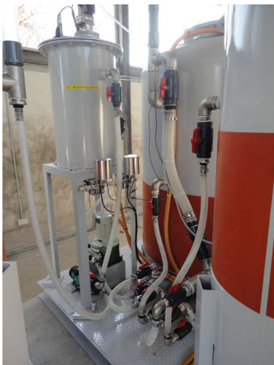
図 5-49 pH 調整槽の完成写真
