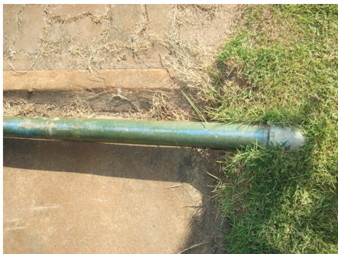
図 5-29 バイオガスプラントのガス配管 -公園食堂の厨房に繋がっている-
