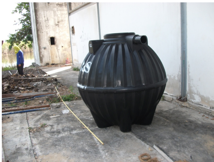
図 5-21 排水処理設備（廢液處理タンク）
