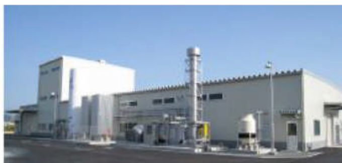
図 24 炭素繊維・複合材料リサイクル実証プラント（福岡県大牟田市）
