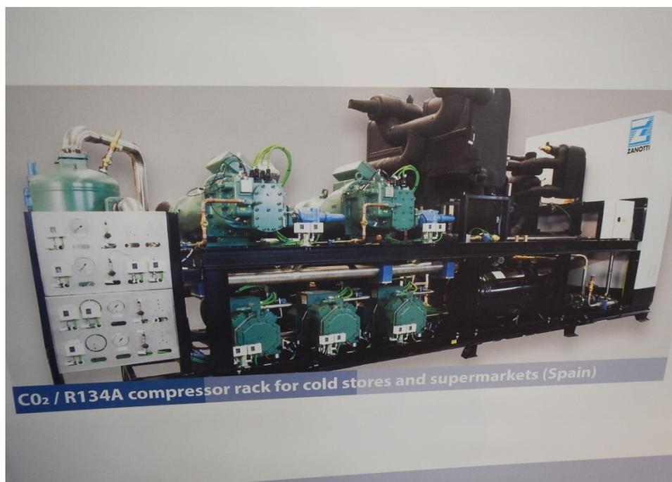
図 3.2.6 CO<sub>2</sub>/R-134a カスケードのコンデンシングユニット (スーパー用)
