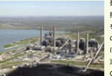
発電所の排ガスから抽出・回収したCO<sub>2</sub>を同州メキシコ湾岸のWest Ranch油田に圧入することで、原油の増進回収を図るCO<sub>2</sub>-EORプロジェクト
