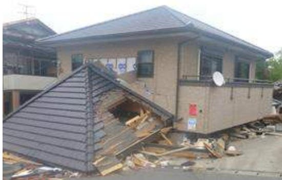
写真-3 2000年以降に建てられたと推定される木造住宅。1階部分が層崩壊している。（撮影：田中圭准教授（大分大学） 7) ）
