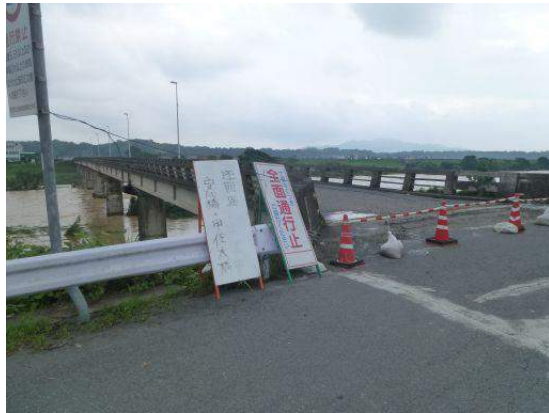
(a) 右岸側橋台部
