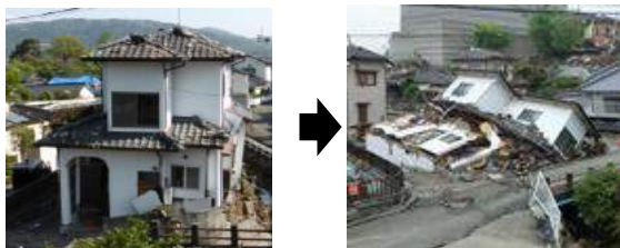
写真-1 14日 M6.5地震後（左）と16日 M7.3地震後（右）の建物被害の比較
