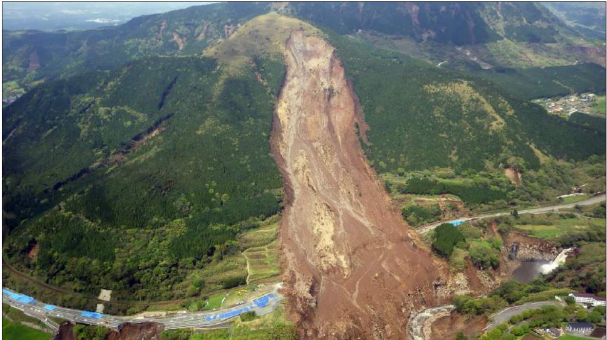
阿蘇大橋を飲み込んだ斜面崩壊の全貌 （写真提供 九州大学 安福規之 教授）
