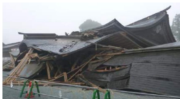
写真-6 倒壊した阿蘇神社の楼門 （撮影：田中圭准教授（大分大学） 7) ）
