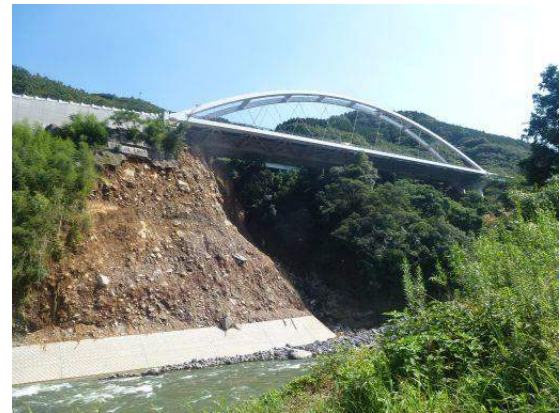
(a) 橋梁全景
