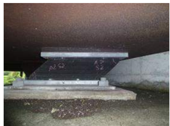
(c) ゴム支承の残留変形
