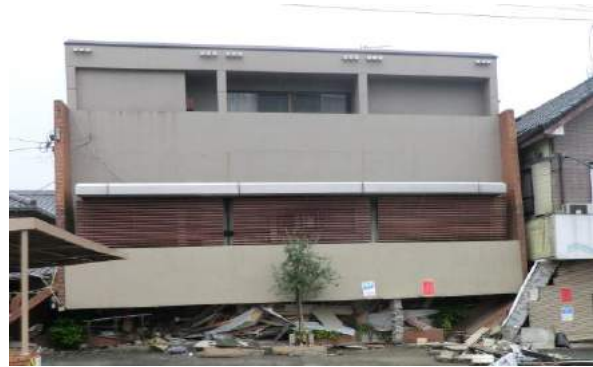
写真-4 倒壊した鉄筋コンクリート造 3 階建ての住宅兼診療所。1 階のピロティ部分が層崩壊している。
