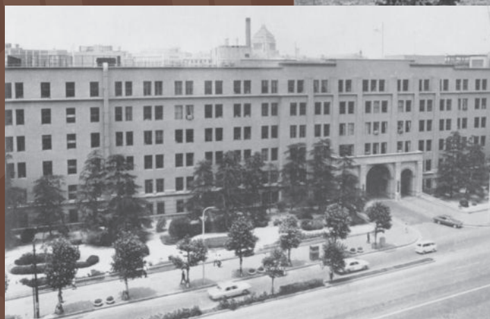
1943年（昭和18年）に完成した 現在の庁舎。昭和44年9月撮影
