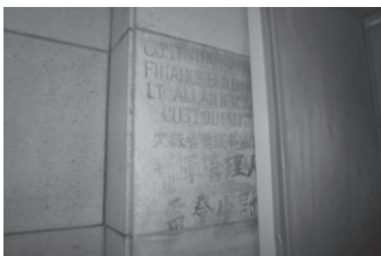
地階の元郵便局横の柱にも、現在は改修工事のため、一部隠れていますが、「CUSTODIANS OFFICE FINANCE BUILDING LT. ALLAN R. WRIGHT CUSTODIAN 大蔵省 管理事務所 米軍管理人 雷登少尉」の文字がかすかに残っています。
