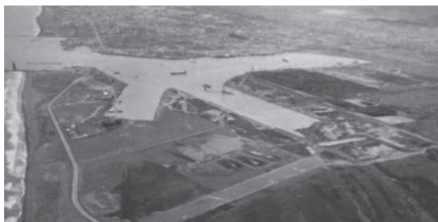
苫小牧港（西港造成中）
