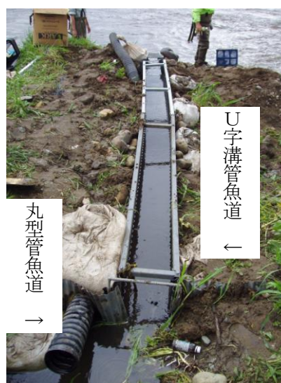
図 1 魚道の設置状況
