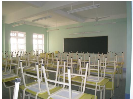
新設工事中の学校の教室
