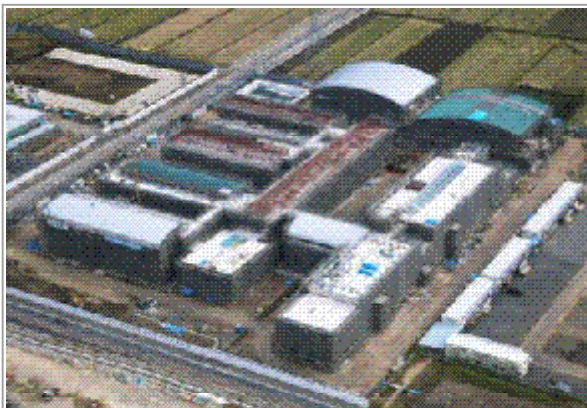
【完成予想図と同一方向から見た工事の状況】 (平成22年10月17日撮影)
