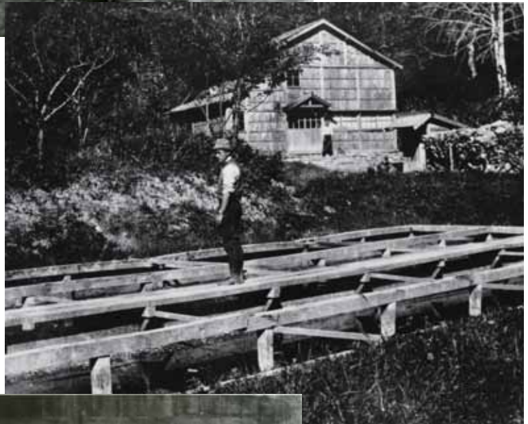
袋沢にあった「鮭人工孵化場」の養魚池
