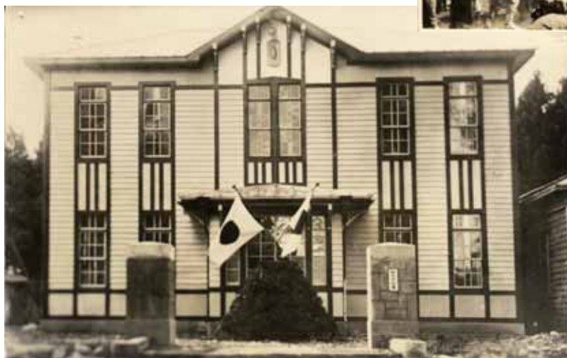
役場庁舎は知内村元町351に建てられ1971(昭和46)年まで使用されていました。
