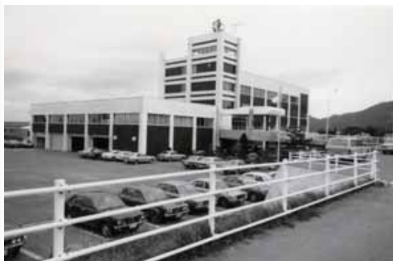
完成時の町民センター
