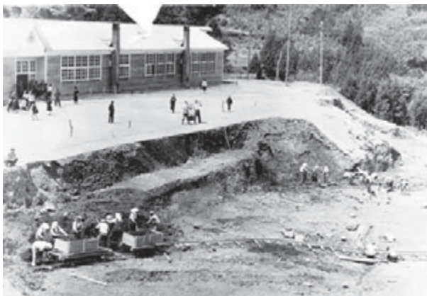
矢越小学校グラウンド整備工事光景 [1953(昭和28)年頃]
