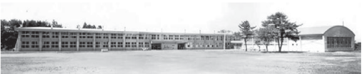
知内小学校[1964(昭和39)年建設の校舎]
