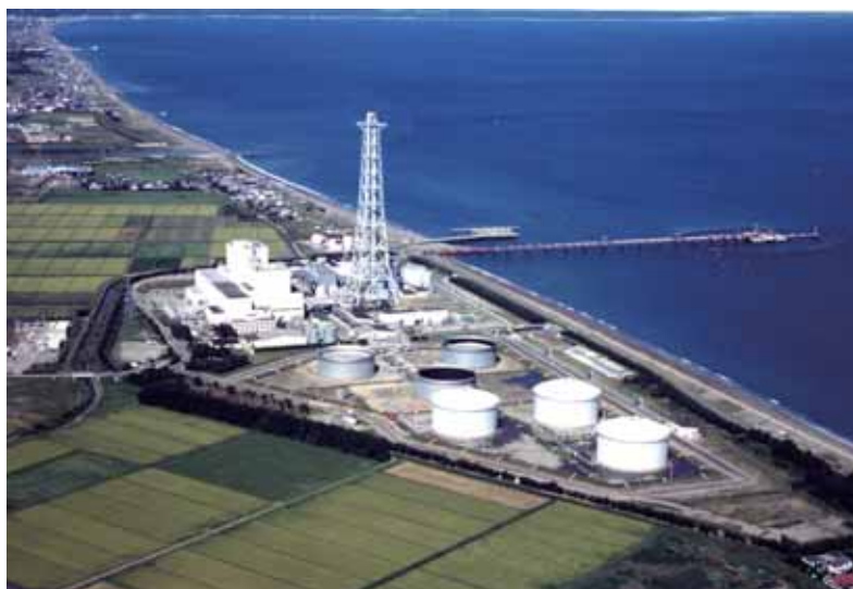
知内火力発電所の全体
