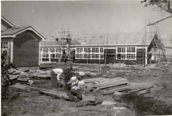
知内高校建設中[1957(昭和32)年]
