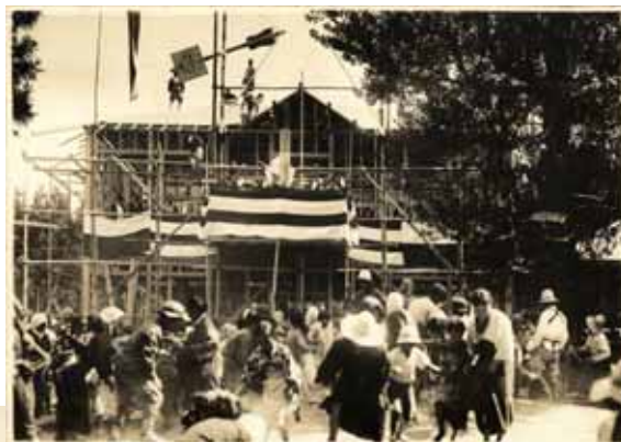
役場庁舎の上棟式 [1931(昭和6)年8月]
