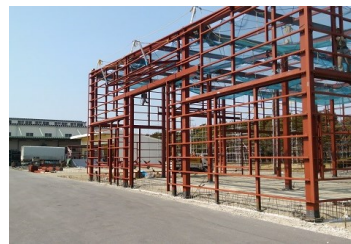
黒龍産業(株)建設中の新工場
