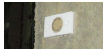
写真-4 打設コンクリートへの IC タグ取付状況
