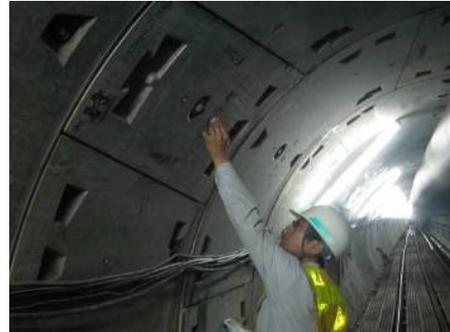
写真-2 セグメントへの IC タグ取付状況
