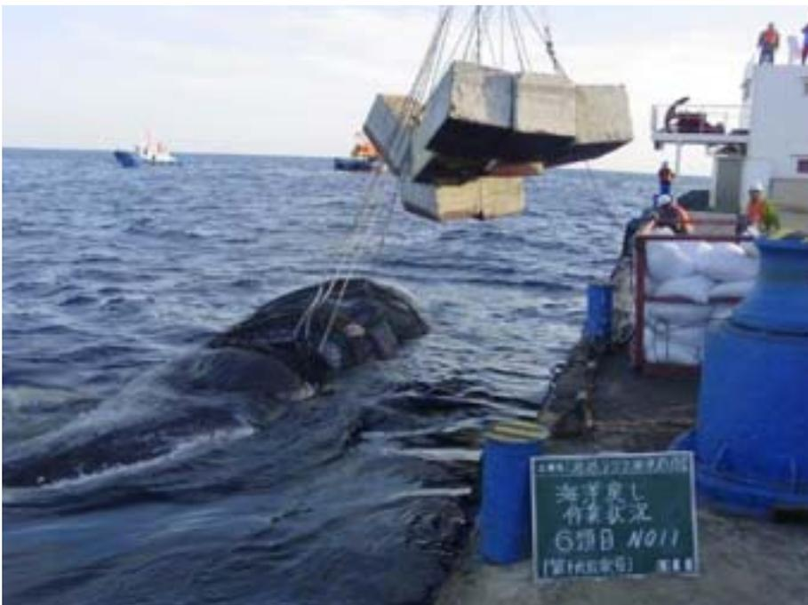
写 VI-7 連結後、方塊を吊り鯨体と共に海底に沈下
