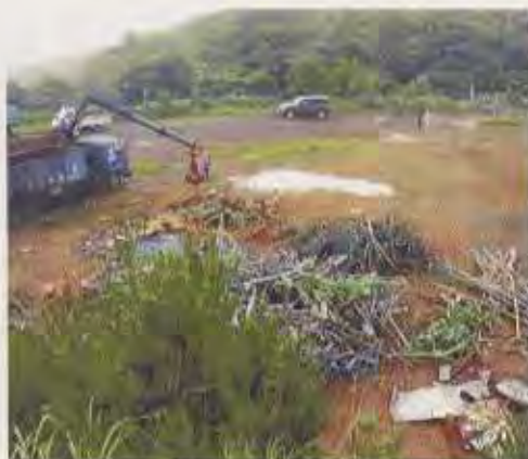
施設発生物品の撤去作業中
