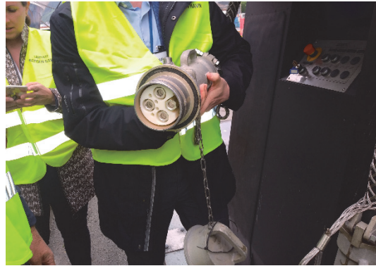
図2 実際のコネクタ（ベルゲン港の Offshore supply vessel）
