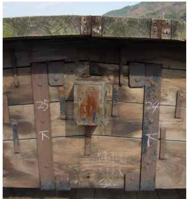
写真 3 アーチ頂部における主桁の一体化
