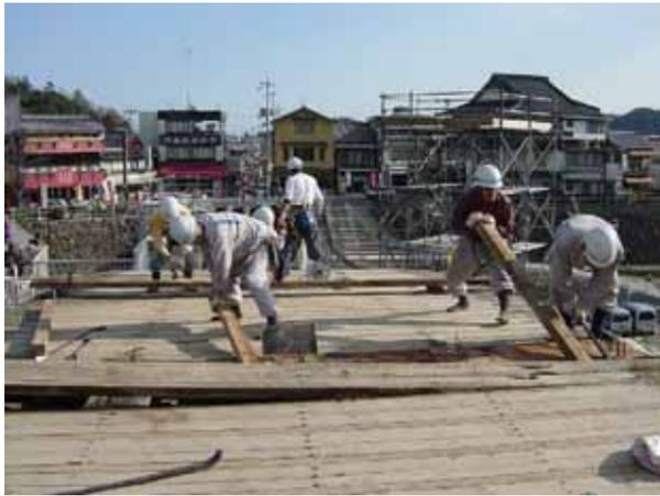
写真9 橋面敷板の撤去作業
