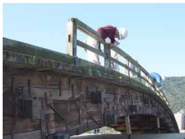
写真8 高欄の撤去作業
