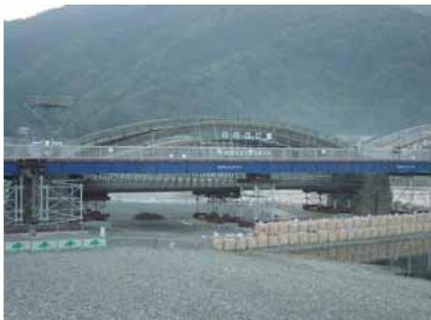
写真6 アーチ橋に平行して建設された迂回路
