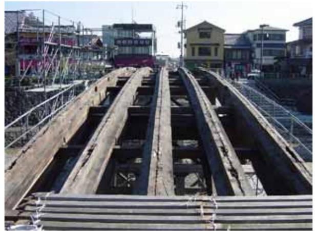
写真10 むき出しになった主桁（桁橋部分）
