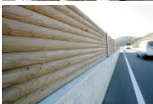
県産品建設資材(間伐材)を使って田辺市に設置した転落防護柵(上)と遮音壁(下)
