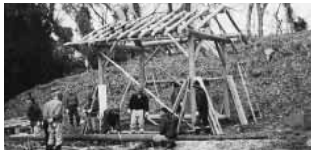
ハイキングコース雨天時の避難小屋建築風景 (現地で伐採した木材を使用)
