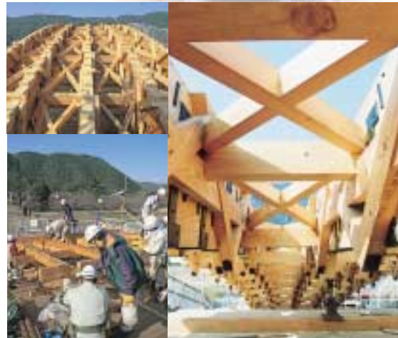
第1期工事の様子
