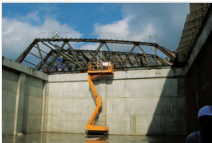
資料収蔵庫北側壁面及び躯体屋根鉄骨組
