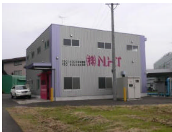
新しい第2工場
