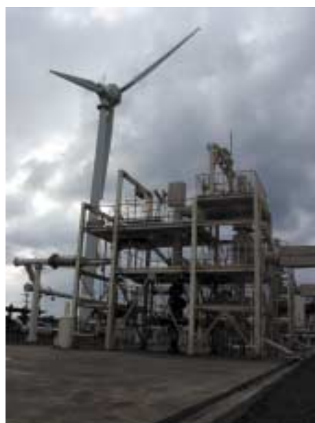
蒸気生産井、その後方が東京電力の風力発電。出力は500kW。発電機までの高さ44m、ブレードの長さは20m
