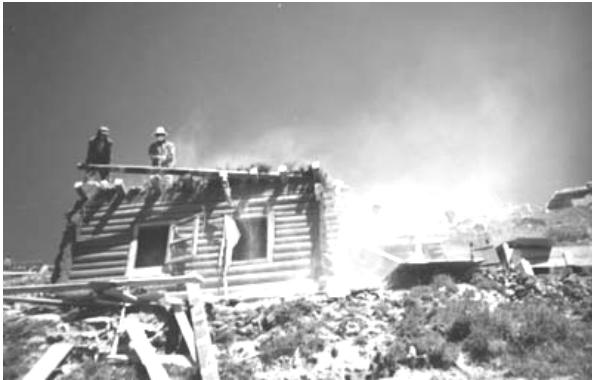
図-6 僧坊を解体する作業員(2001年6月～7月)
