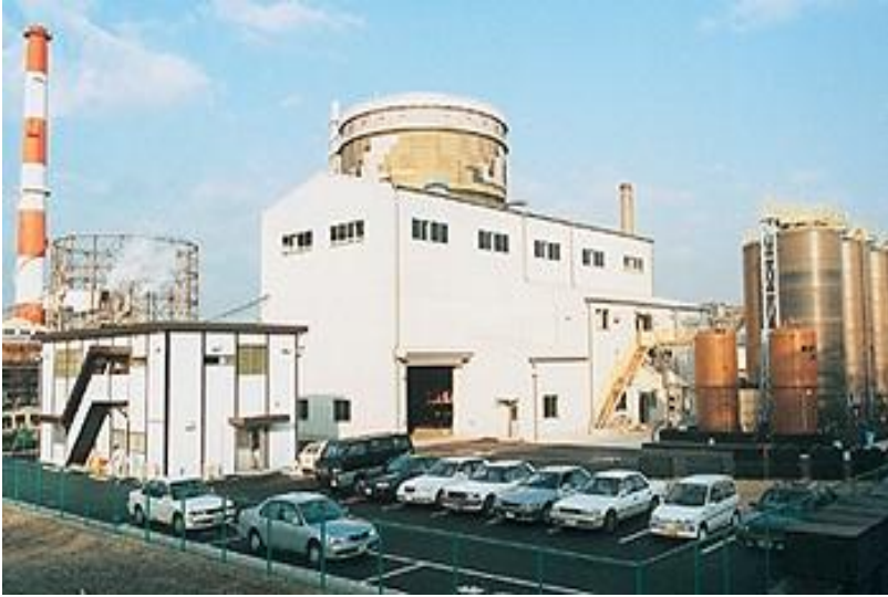
塩化鉄廃液再処理工場(広畑工場)全景(アステック入江HPより抜粋)
