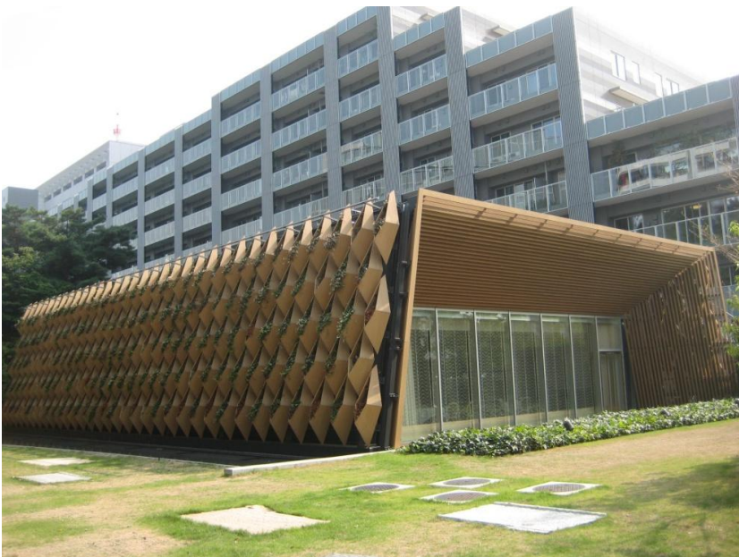
写真：パークコート神宮前のパブリックスペース・WPCを使用した施工例（2010年9月21日、インタビュー者撮影）
