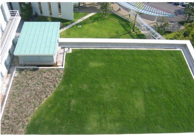
△写真左:アースコンシヤス株式会社屋上緑化用植物栽培用“エコグリーンマット”施工事例:徳島市民病院(2010年9月8日、インタビュー撮影) △写真右:同上:徳島赤十字病院(アースコンシヤス株式会社提供)
