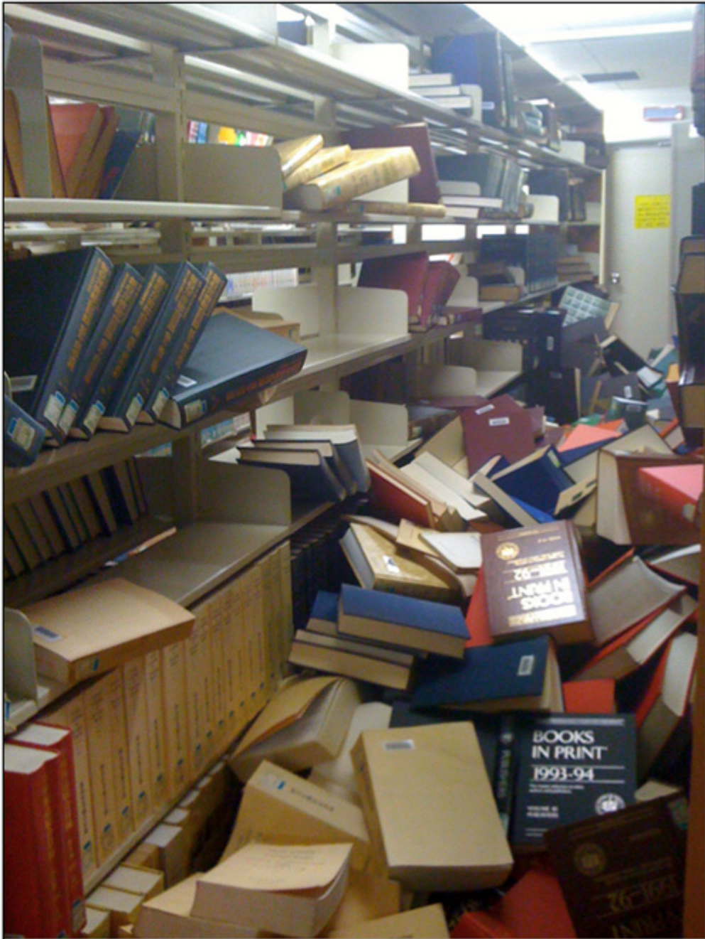
(写真2)書架被害2(3階)参考図書類。下段の資料が地震で前方にずれ、上段の資料の落下時に引っかかって連鎖的に両方とも落ち、背表紙の破損なども生じた。
