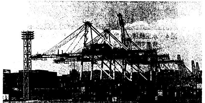
図9 コンテナクレーンの概観 スプレッドの振れ止め制御を実施しているクレーン。 Outline view of container crane
