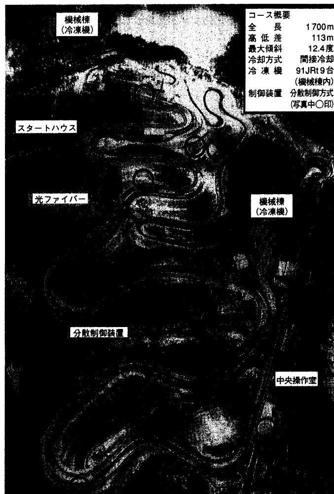
図6 ボブスレー・リュージュトラック全景とDCSの配置 全長1.7kmのトラック沿い13箇所にDCSが配置され光ファイバーで接続されている。(写真は読売新聞社撮影) Panorama of bobsleigh and luge track and DCS arrangement
