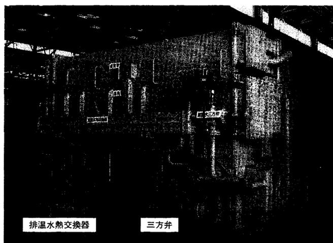
図2 排熱投入型直置き吸収冷凍機 従来型直置き吸収冷凍機に排温水熱回収用熱交換器と三方弁を付加している。
