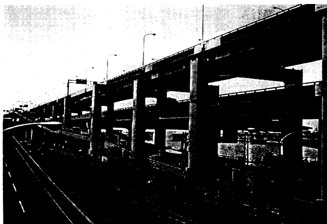
神戸港港湾幹線道路橋脚復旧工事
