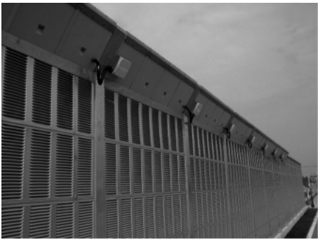
図3 ASE遮音壁外観 神戸造船所二見工場（兵庫県明石市）ITSテストコース内に設置したASE遮音壁。平面状の統一型遮音パネルの頂部に設置される。ASE noise barrier on the ITS test course, at Hyogo Japan.
