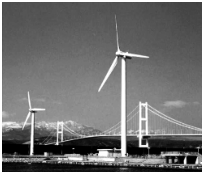
室蘭市祝津発電所 1000 kW 風車 大容量化が容易な自然エネルギー利用発電プラント
