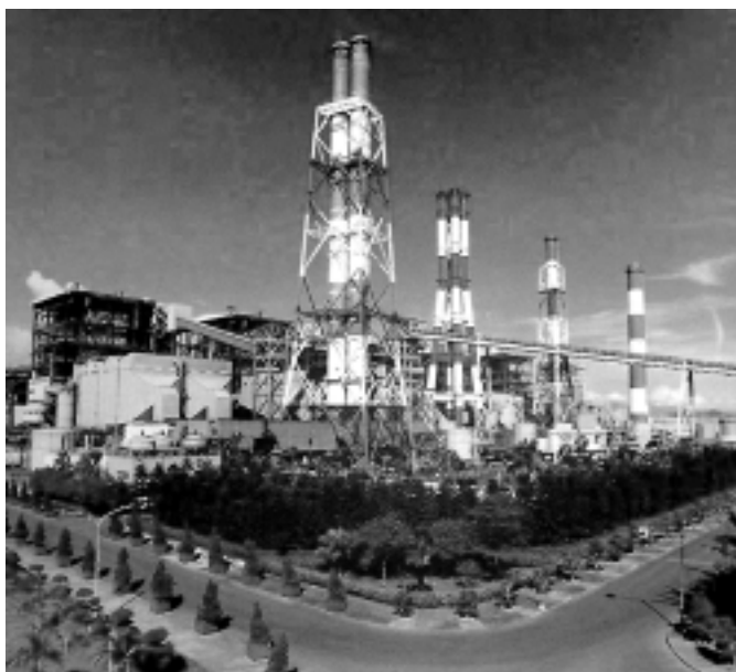
台湾大林発電所低 NOx 化改造工事 低 NOx 燃焼技術の導入により、環境問題の改善に貢献
