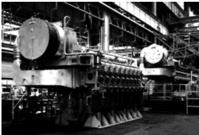
MACH-30G ガスエンジン 世界最高レベルの発電効率42.5 % 及び低 NOx 達成
