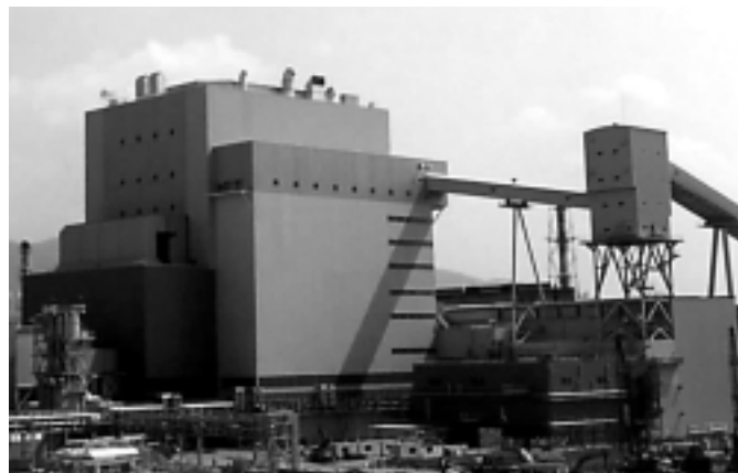
神戸製鋼(株)神戸発電所 国内最大のIPP 700 MW 石炭だき発電設備 24.1 MPa , 538 /566
