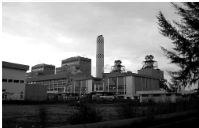
シンガポールチュアス発電所 720 MW コンバインドサイクルプラント シンガポール初のF形軸（2系列）コンバインドサイクルプラント
