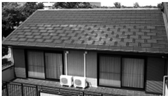
アモルファスシリコン太陽電池 個人でも環境保全に貢献できる住宅用瓦一体型システム
