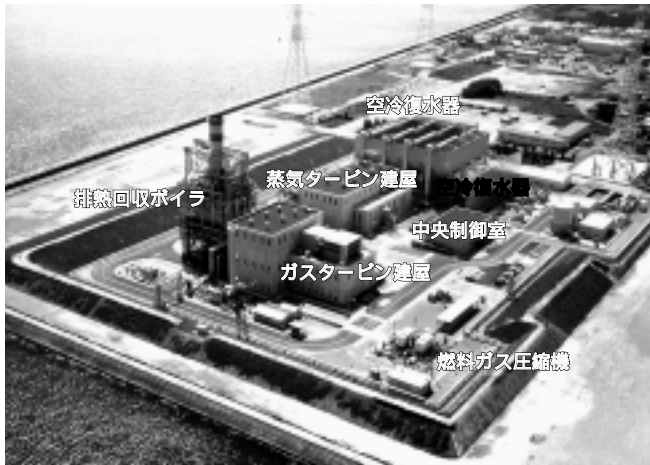
図2 ガスタービン複合サイクル発電プラント実証設備（T地点） H形ガスタービン試運転を行った高砂製作所内実証発電設備。
