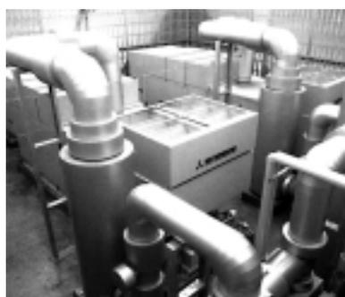
図13 脱硝装置
