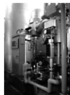
図14 排ガス蒸気ボイラ
