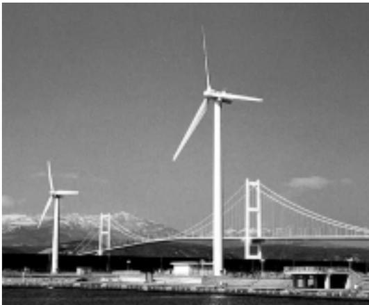
図16 室蘭490 kW及び1 000 kW風車
