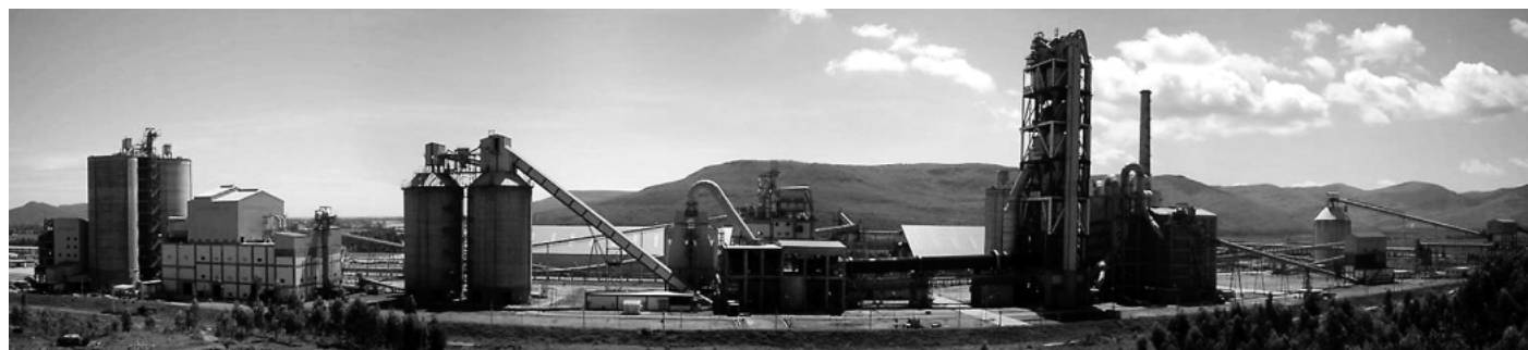
図1 セメントプラント全景 右から原料工程、焼成工程、仕上げ工程。
