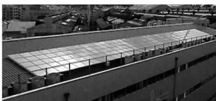
図9 工場用太陽光発電システム 工場用太陽光発電システムの設置例を示す。
