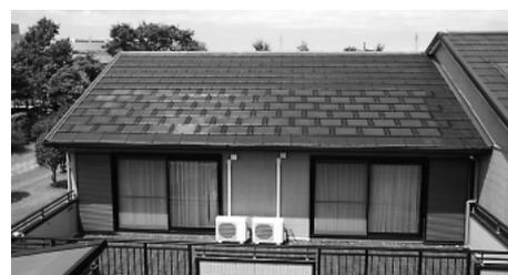
図8 住宅用太陽光発電システム（屋根一体型） 住宅用として開発された屋根一体型太陽光発電システムの設置例を示す。
