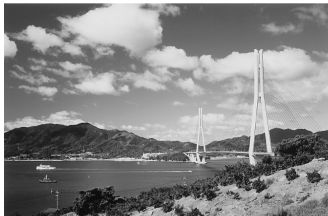
図1 斜張橋（多々羅大橋：しまなみ街道，広島県～愛媛県）
