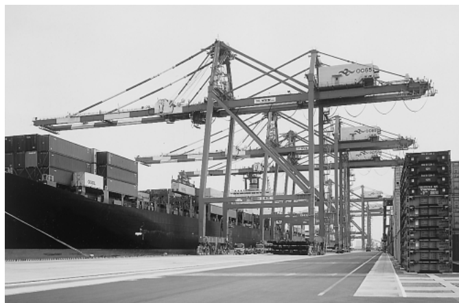
図7 コンテナクレーン（東京港大井コンテナ埠頭）
