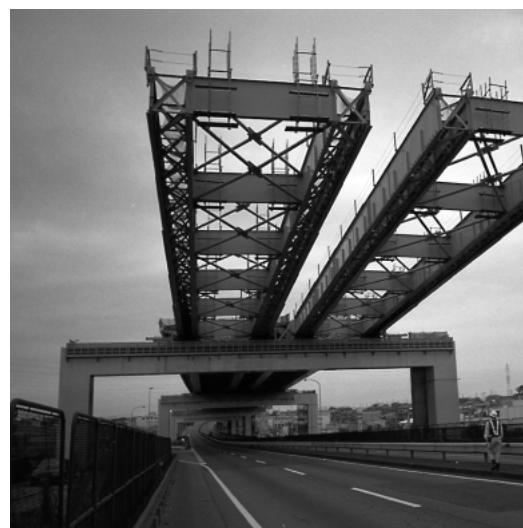
図3 手延べ送り出し架設 第5回送り出し完了直後の状況。
