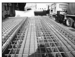
⑤ 上面鉄筋配筋
