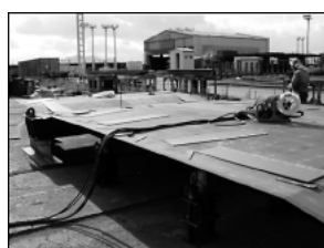
① 底鋼板パネル製作
