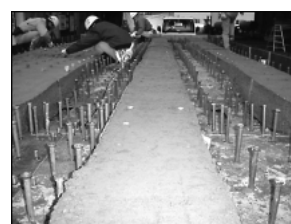
③ 1次コンクリート打設
