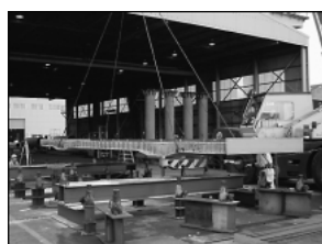
④ 運搬、主桁上に設置
