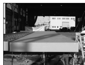
⑥ 2次コンクリート打設
